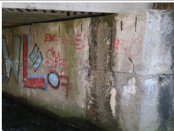
Foto č. 11 Opěra O 01 – ÚP vlevo - průsaky vody, degradace, obnažená výztuž
