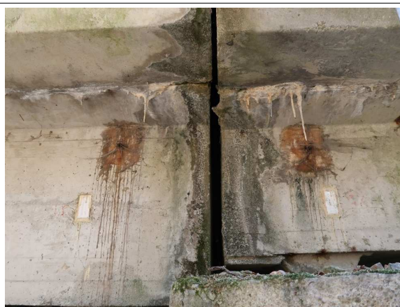
Foto č. 8 Konstrukce K 02/K 03 - dilatace zleva nad P 02 - degradovaný beton
