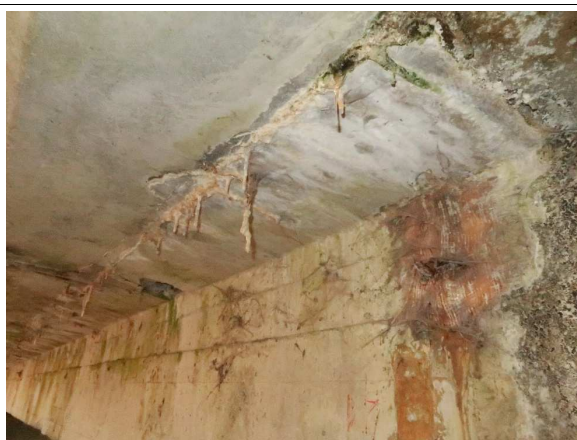
Foto č. 7 Konstrukce K 02– L. HL. N. podhled začátek – degradovaný beton, výluhy pojiva
