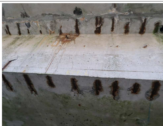
Foto č. 4 Konstrukce K 01 – L. HL. N. zleva – degradace, trhliny, výluhy
