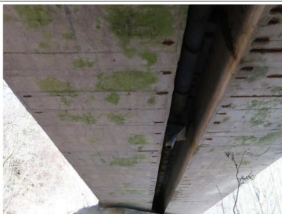
Foto č. 9 Konstrukce K 03 – P. HL. N. podhled proti, koroze výztuže
