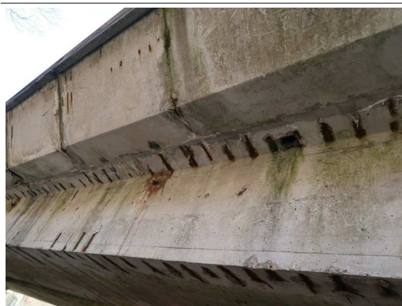
Foto č. 3 Konstrukce K 01 – L. HL. N. zleva – degradace, trhliny, výluhy
