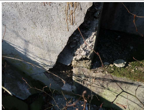
Foto č. 12 Opěra O 01 - závěrná zeď vpravo - degradovaný beton
