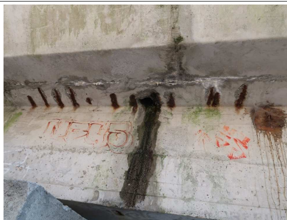
Foto č. 10 Konstrukce K 03 - L. HL. N. zleva konec – průsaky, výluhy, degradace betonu, trhliny
