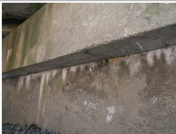
Foto č. 13 Pilíř P 02 – z 3. otvoru úložný práh podhled - trhlina s výluhy pojiva
