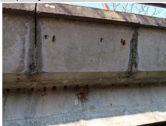
Foto č. 5 Konstrukce K 01 – P nosník obnažená výztuž
