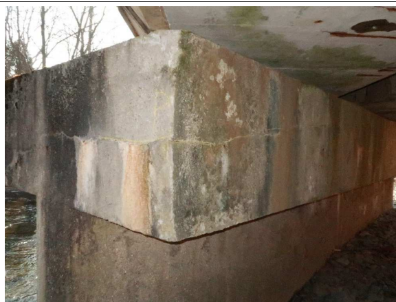
Foto č. 14 Pilíř P 02 – zprava ÚP - trhlina s výluhy pojiva
