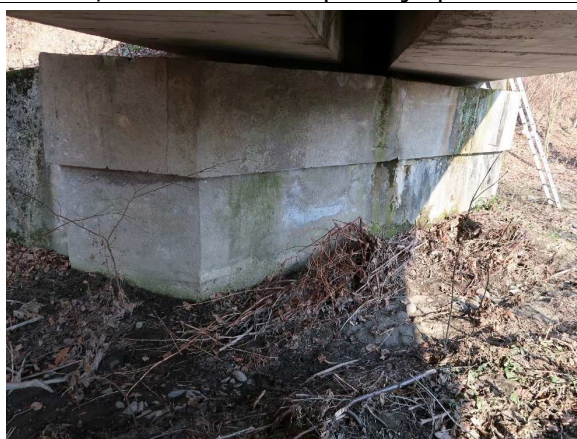
Foto č. 15 Opěra O 02 – stékání vody, výluhy, trhliny
