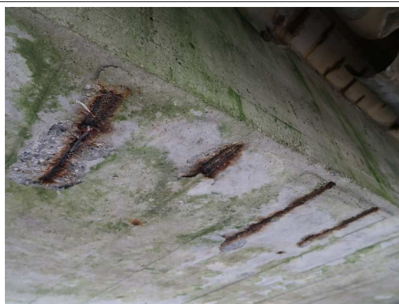
Foto č. 2 Konstrukce K 01 – L nosník, podhled, obnažená výztuž
