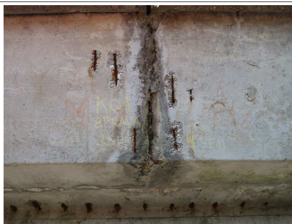
Foto č. 6 Konstrukce K 01 – P nosník obnažená výztuž
