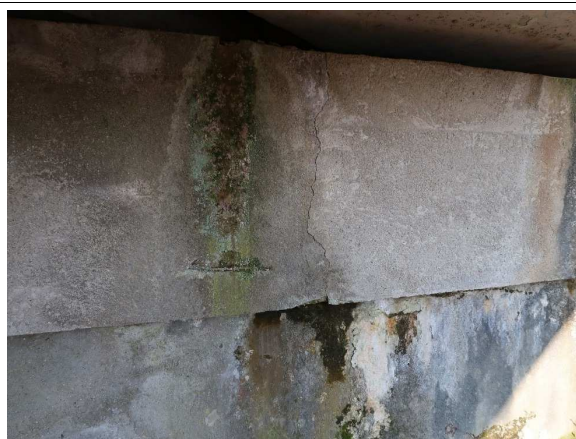
Foto č. 16 Opěra O 02 – ÚP - trhlina
